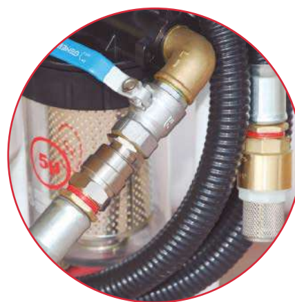
Conexiones de filtros
